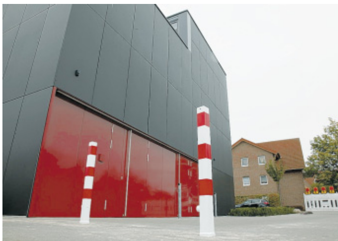
Dicht gemacht: Zwei rot-weiße Sperrpfosten verhindern seit einer Woche die Durchfahrt von der Lindenstraße zur Bahnhofstraße unmittelbar nördlich der Bahnschienen. Die Stadt will damit auf der „heimlichen Umgehung“ die Verkehrssicherheit erhöhen. FOTO: ROLAND THÖRING
